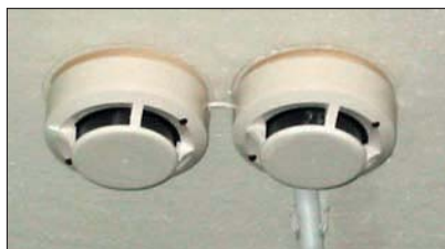
Рис. 7. Расстановка извещателей для двойного контроля помещения
