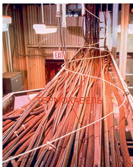
Рис. 4. Расположение термокабеля на кабельном лотке
