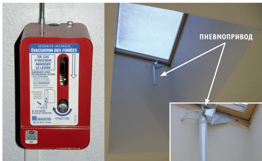
Рис. 4. Система SHEVS. Слева пульт с механическим управлением, справа фрамуга в потолке с пневматическим управлением
