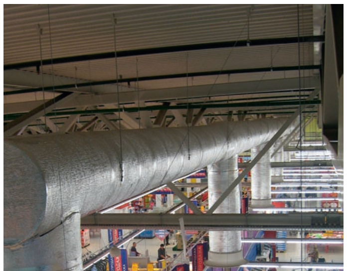
▲ Рис. 3. Пространство под перекрытием в торговом зале
