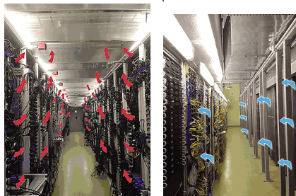
Рис.3. Горячий коридор (сверху) отделен от основного объема помещения
