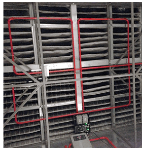
Рис. 4. Расположение труб ИПДА на воздухозаборе системы охлаждения
