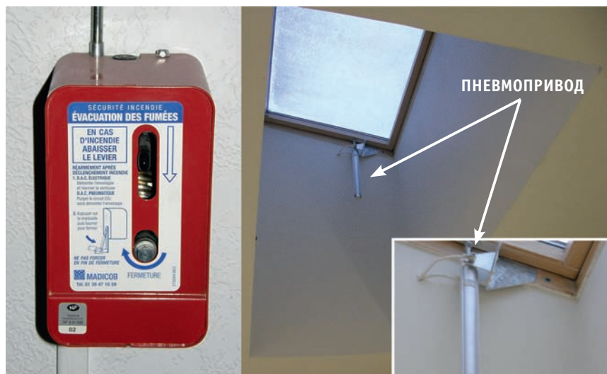
Рис. 4. Система SHEVS. Слева пульт с механическим управлением, справа фрагма в потолке с пневматическим управлением
